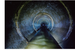
市政管道检测
